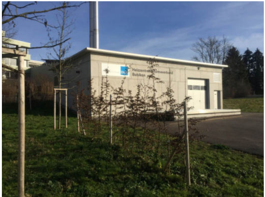
Wärmeverbund der EKZ in Bubikon
