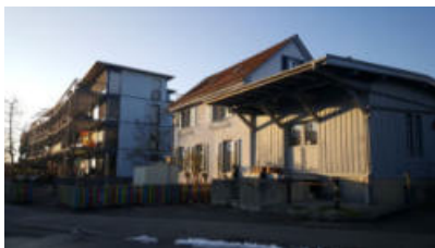
Alter Bahnhof Wolfhausen
