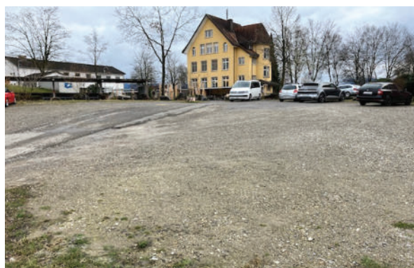
29 Wolfhausen, Kiesparkplatz Fosberg
