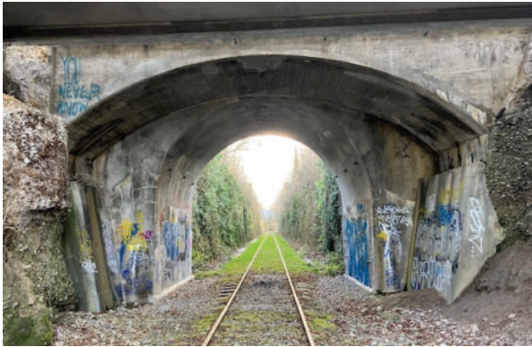
48 Bubikon, Unterführung nahe Ritterhaus
