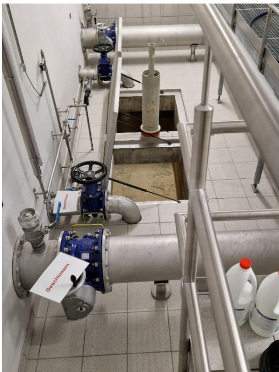
Einblicke in den Rohrkeller und
